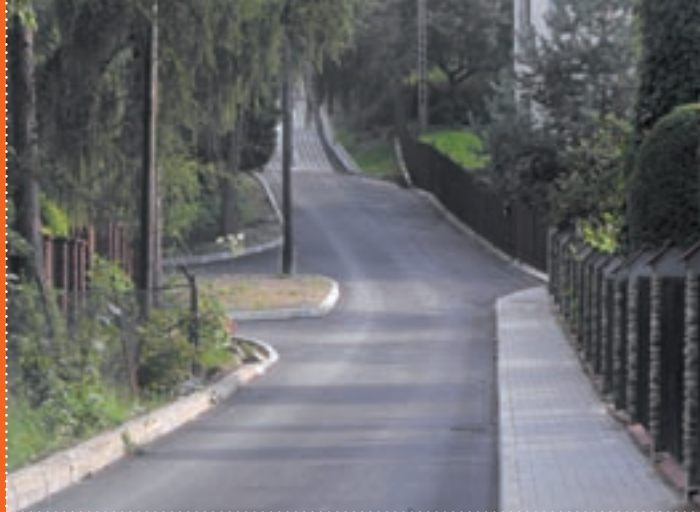
Wyremontowana ulica Ogrodowa
