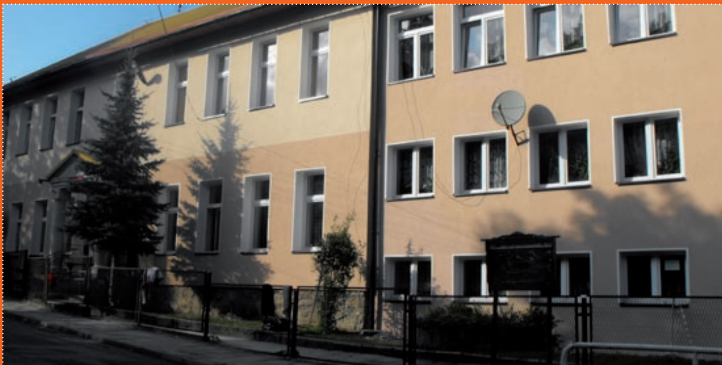
Termomodernizacja budynku filii Szkoły Podstawowej Nr 2
