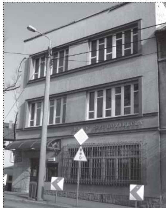
Siedziba Banku Spółdzielczego w Suchej Beskidzkiej przy ul. Piłsudskiego 5
