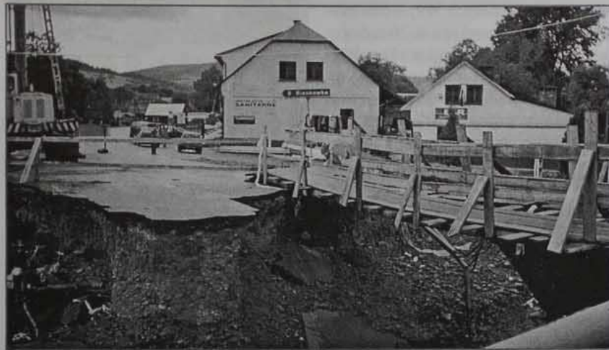
Zerwany most w Budzowie
