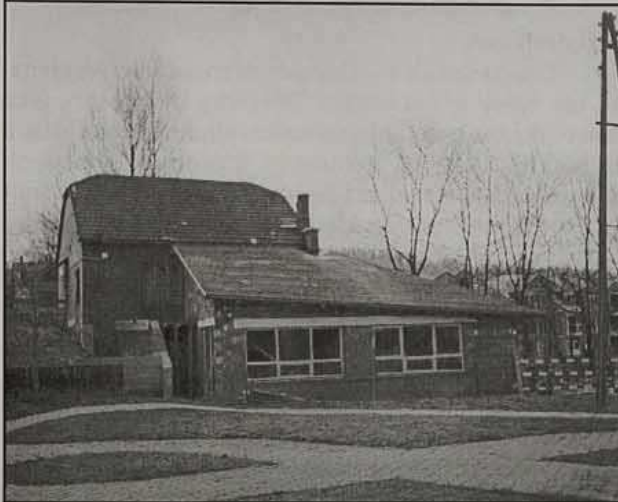
Budynek zaadaptowany na potrzeby świetlicy
