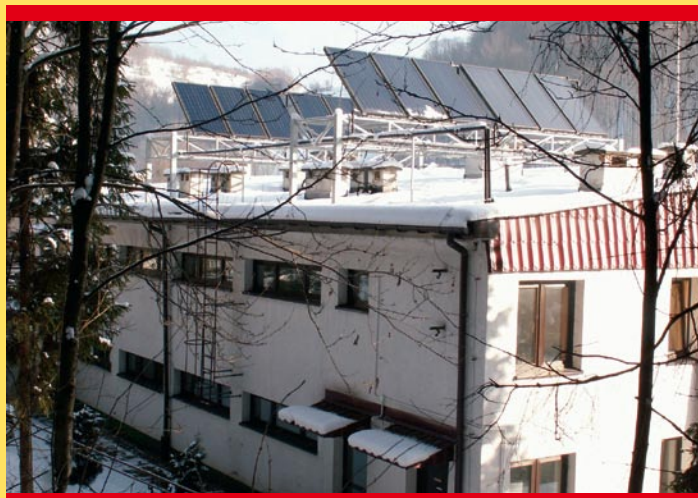
Dom Pomocy Społecznej w Makowie Podhalańskim, budynek C
