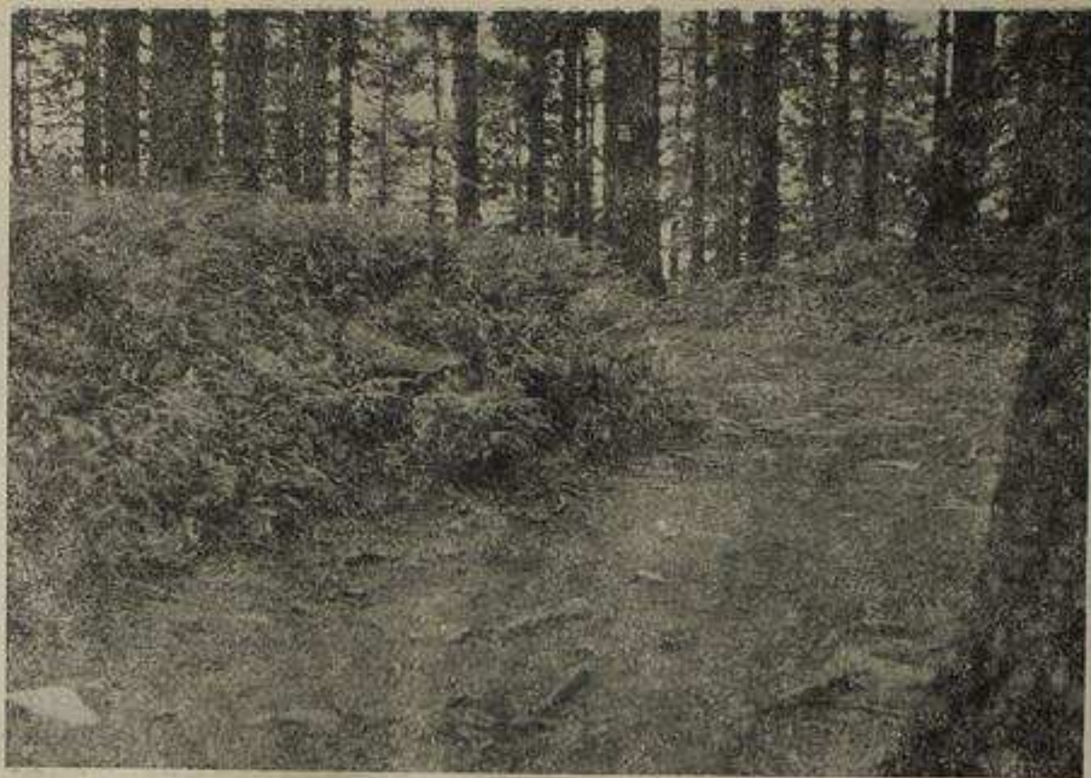
Górny Plaj na odcinku w pobliżu Markowego Stawku. Zniszczenie szlaku wywołane przez turystów — obnażanie korzeni drzew i skał podłoża szlaku spowodowane rozdeptywaniem
