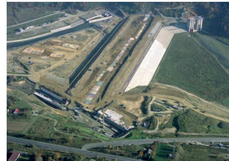
Technologia wbudowywania gliny. Na lewo deponia, na prawo układanie (głina częściowo przykrywana plandekami).
