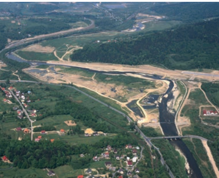
Czasza zbiornika w części cofkowej i środkowej.
