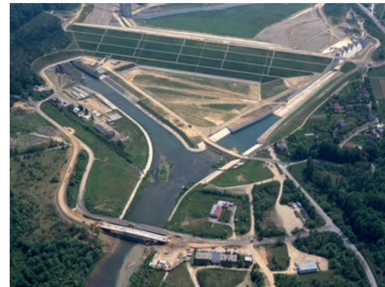
Widok rejonu stopnia czołowego zapory.
