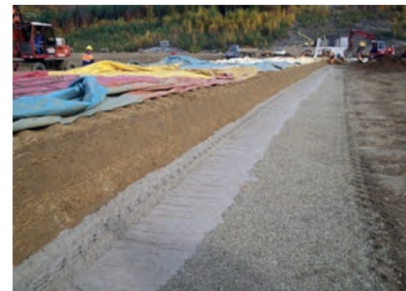
Profil rdzenia obudowanego filtrami piaskowym i żwirkowym.
