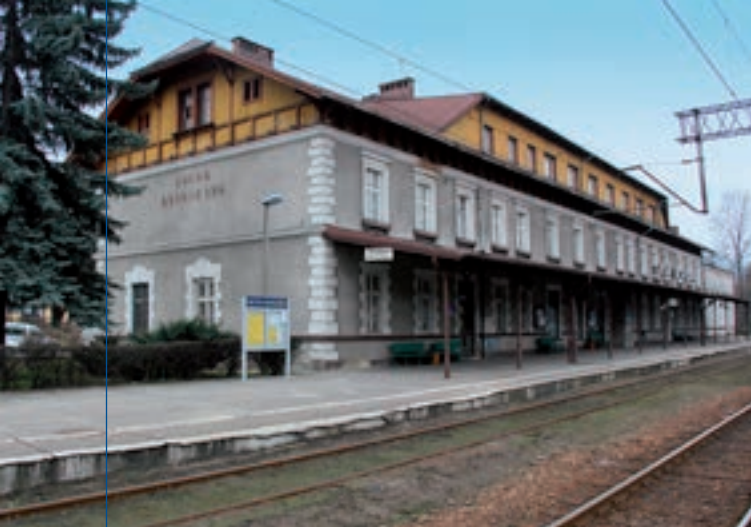
Budynek dworca kolejowego. Fot. Monika Spyrka
