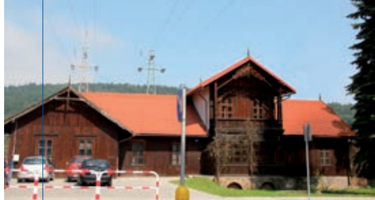
Drewniana willa dworska przy ul. Mickiewicza 40. Fot. Monika Spyrka
