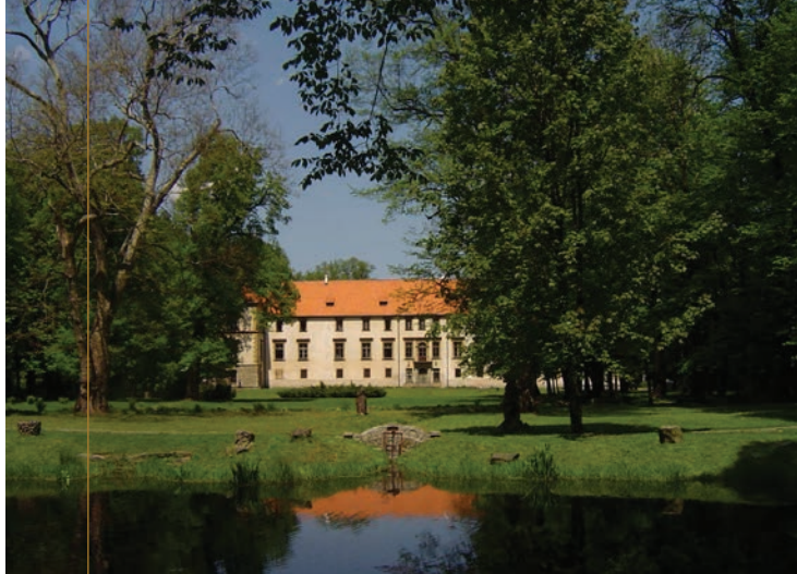
Zamek. Widok od strony parku na południową elewację obiektu. Fot. BW
